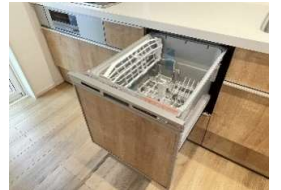
2号棟/食器洗浄乾燥機
